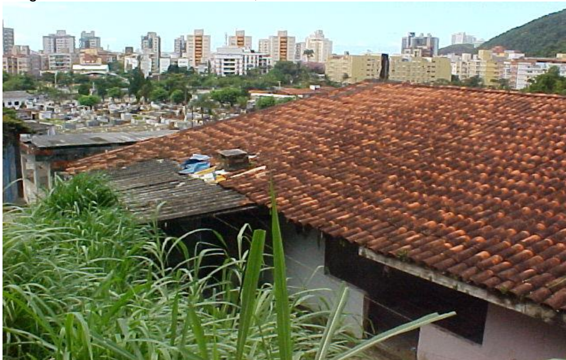
Fotografia 14: Talude de corte a 90°, com 2 metros de altura. Vila Julia.
