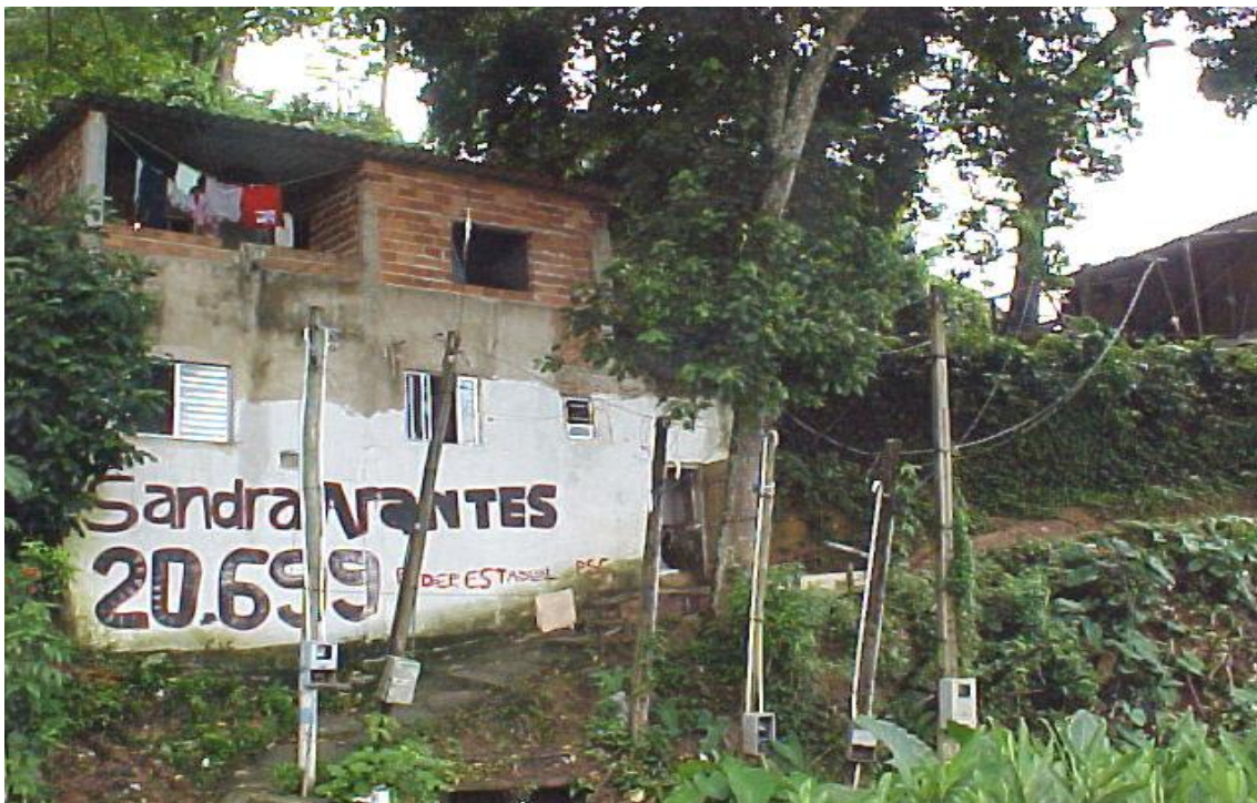
Fotografia 30: Casas com ampla alvenaria, fixada em talude de corte e aterro. Jardim Três Marias.
