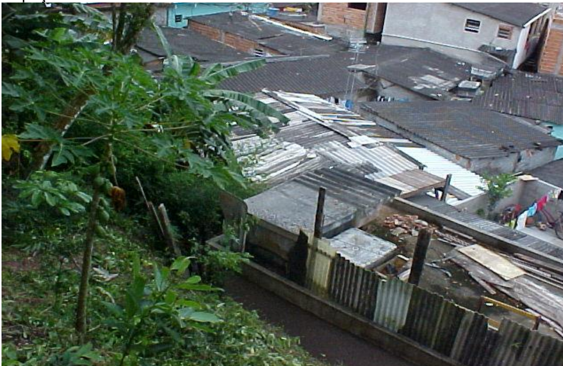
Fotografia 15: Distribuição das casas em áreas planas (consolidadas), de maneira informal. Observa-se a distância insegura entre o talude e as ocupações.
