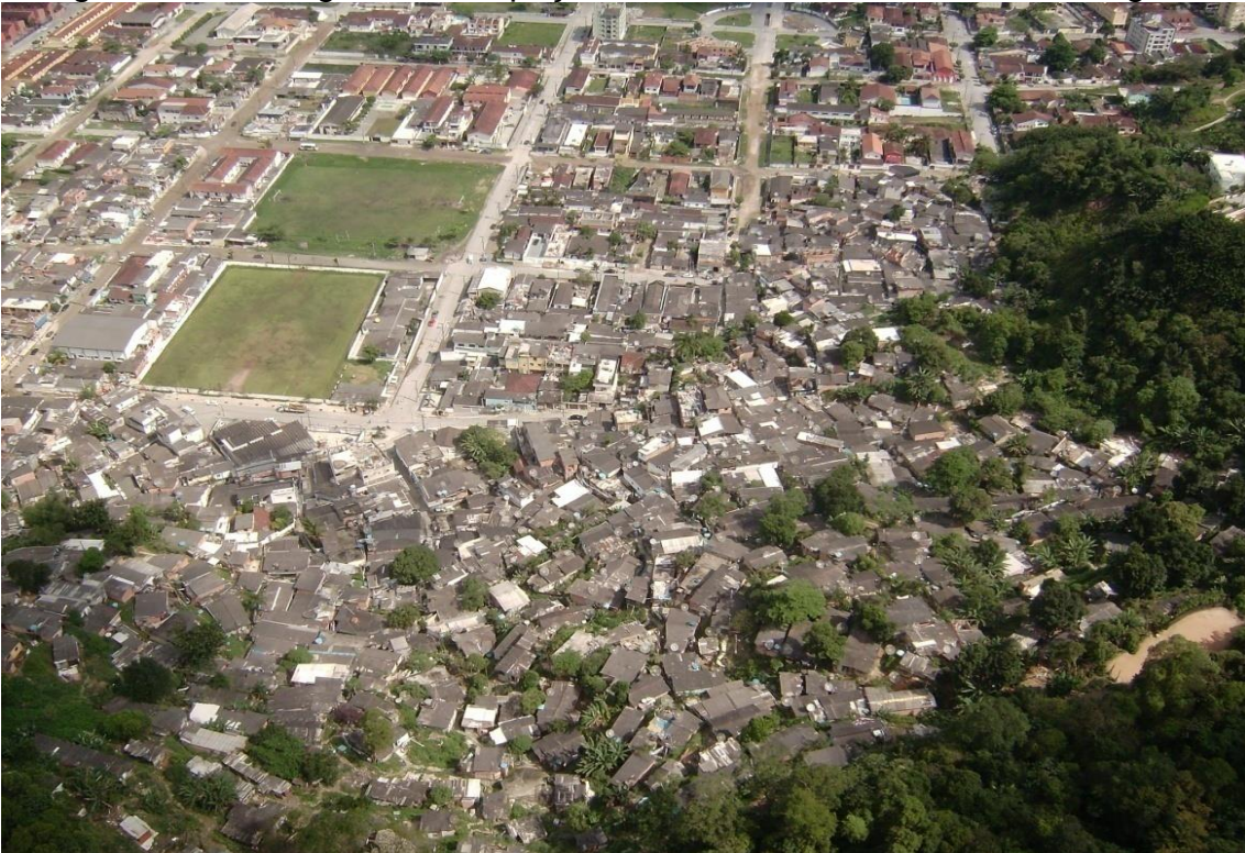
Fotografia 35: Vista geral da ocupação em conexão com loteamentos regulares.
