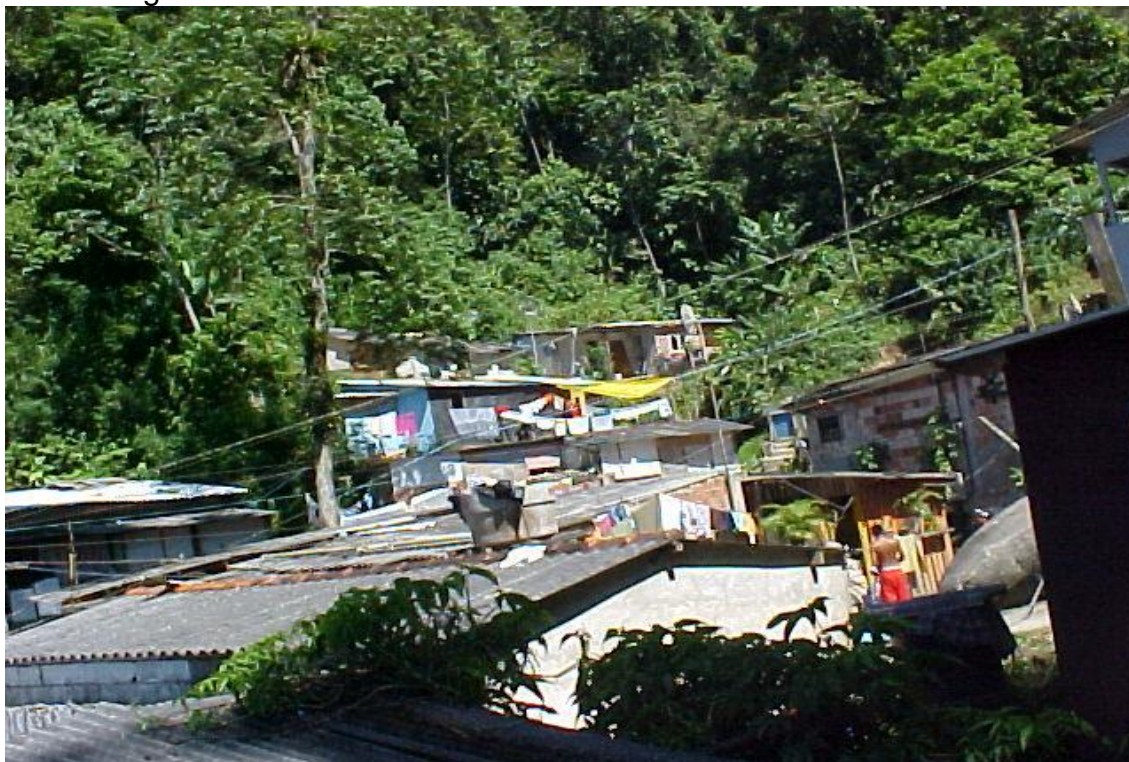
Fotografia 23: Casas mistas, instaladas em taludes de corte e aterro sobre encosta íngreme. Vale da Morte.
