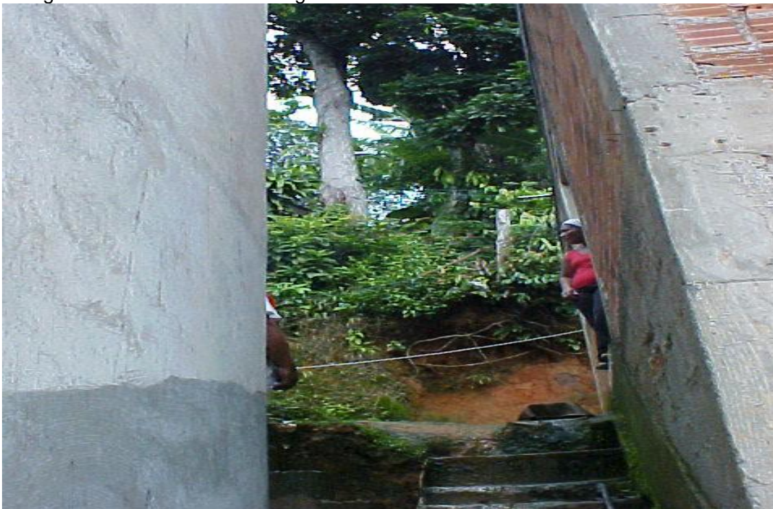
Fotografia 33: Talude de corte íngreme no fundo da residência. Jardim Três Marias.
