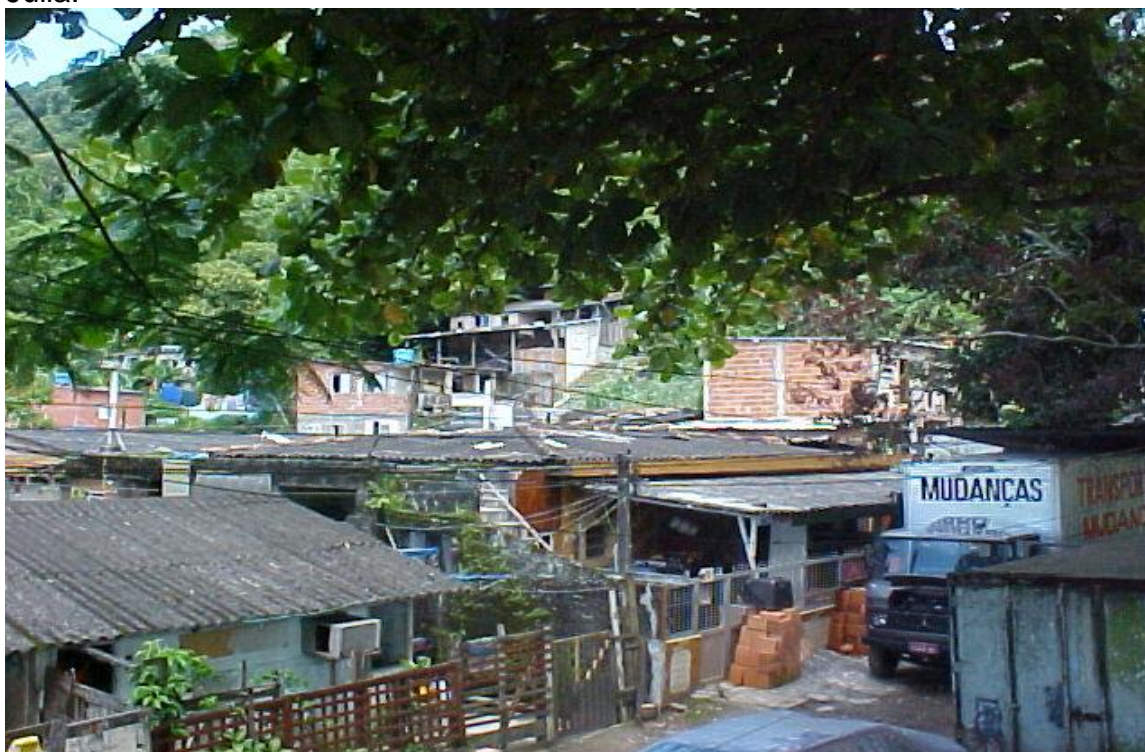
Fotografia 13: Construções de moradias com alvenaria e madeira (misto). Vila Julia.
