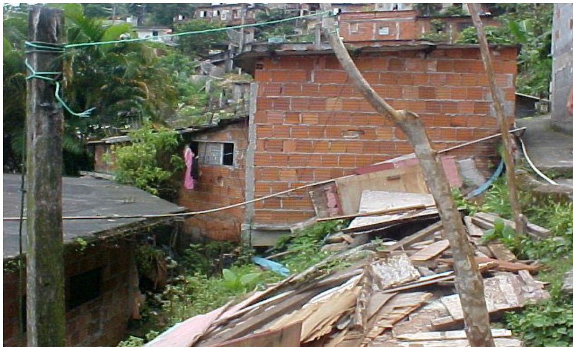
Fotografia 50: Depósito de entulho em talude bem próximo às moradias de base. Vila Baiana.
