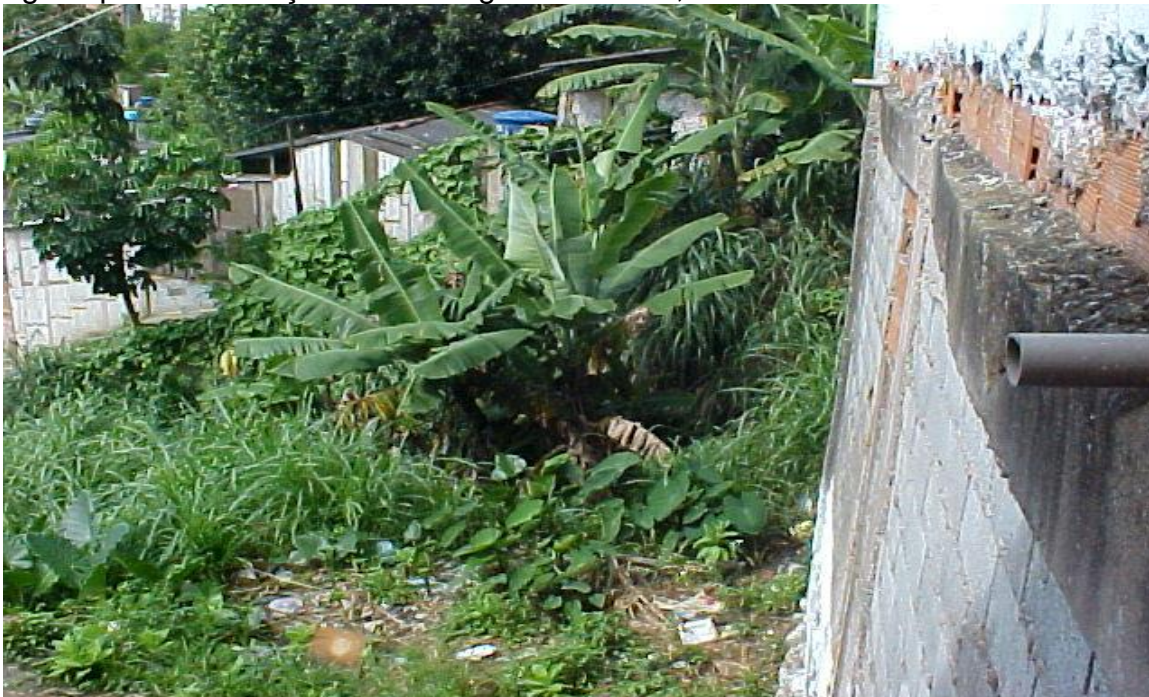
Fotografia 08: Talude de aterro em meio às casas. Área de concentração de águas pluviais e lançamento de águas servidas, lixo e entulho. Vila Júlia.
