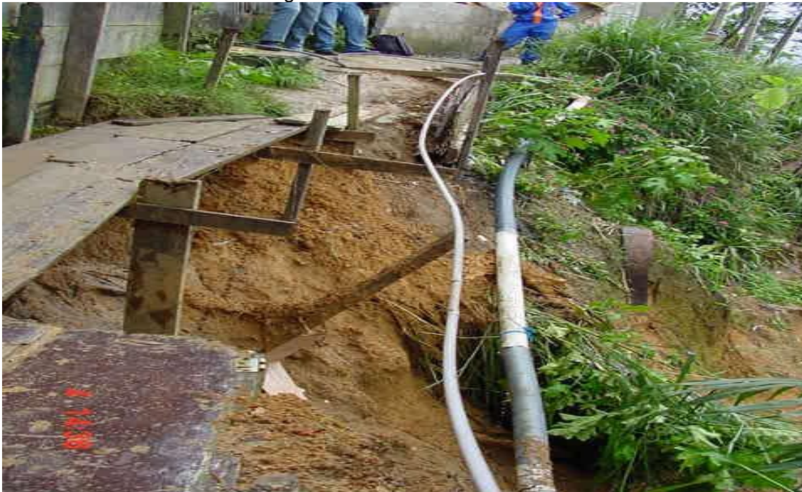
Fotografia 02: Tubulações de abastecimento de água e de lançamento de esgoto realizadas informalmente na região da Vila Baiana.
