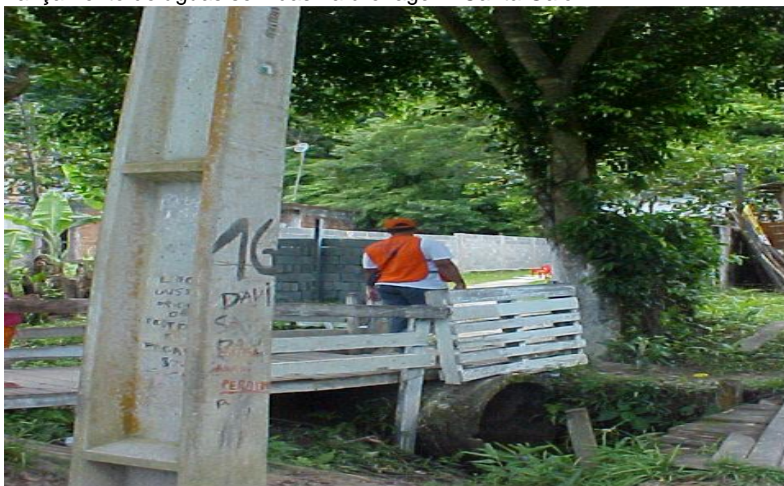
Fotografia 61: Observam-se construções precárias para acesso a outras moradias, como pontes de madeira sobre drenagem natural retificada. Lançamento de águas servidas na drenagem. Canta Galo.
