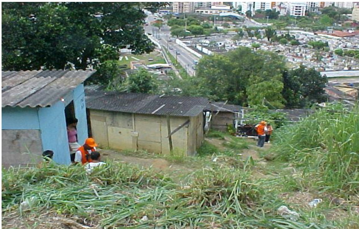
Fotografia 12: Casas próximas à encosta natural, implantadas em baixos taludes de corte. Vila Julia.
