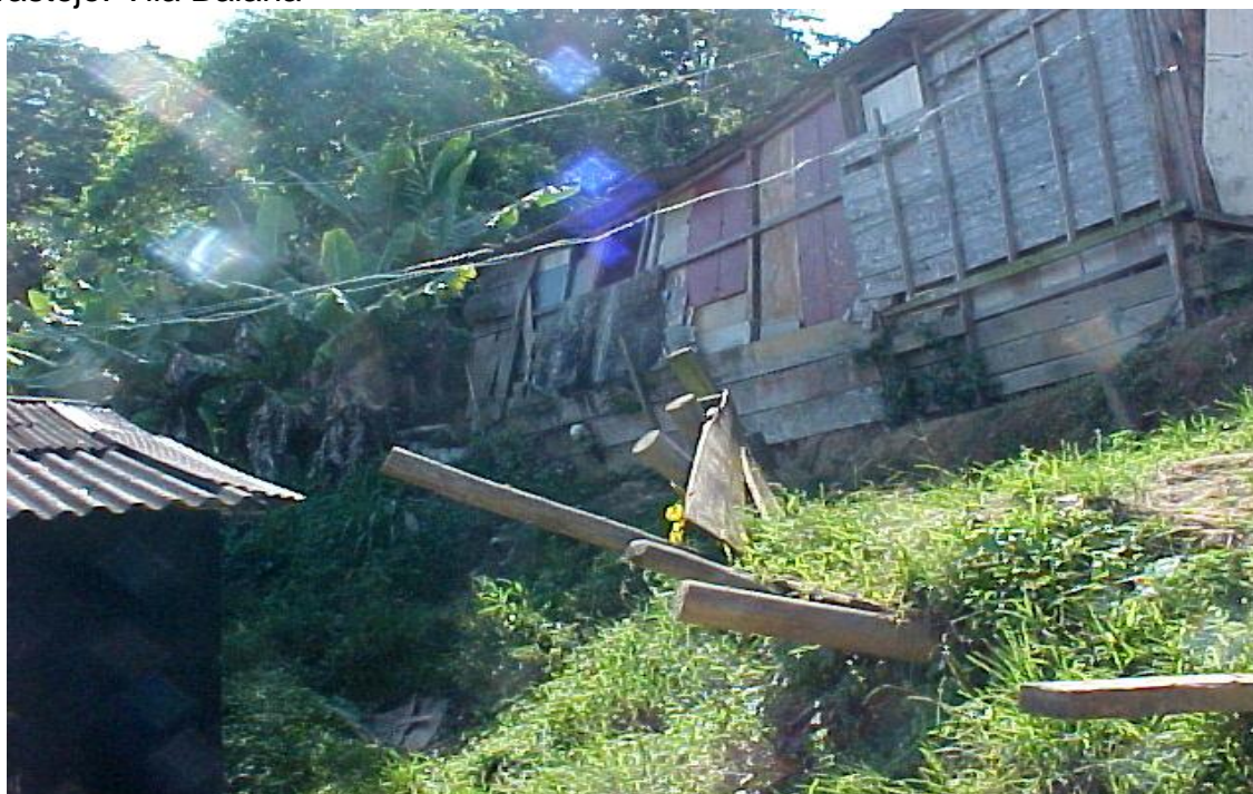
Fotografia 45: Detalhe de talude de aterro. Antiga cerca foi inclinada por ação de rastejo. Vila Baiana
