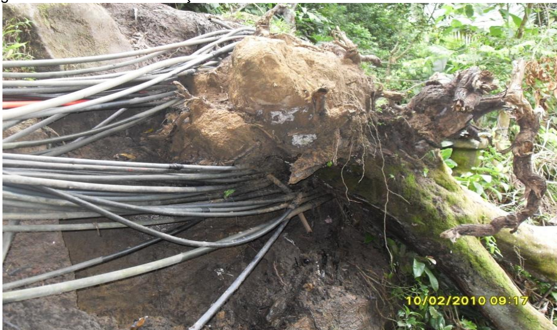
Fotografia 04: Tubulações que abastecem, de maneira precária, as moradias danificadas pelo tombamento de uma árvore, acarretando a ruptura destas e gerando vazamento e filtração no solo. Vila Baiana.
