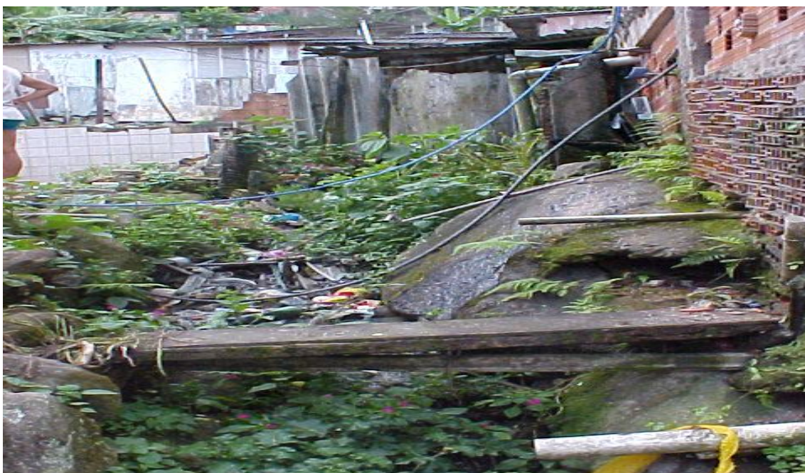
Fotografia 55: Drenagem natural convertida em ponto de lançamento de água servida e lixo. Vila Baiana.
