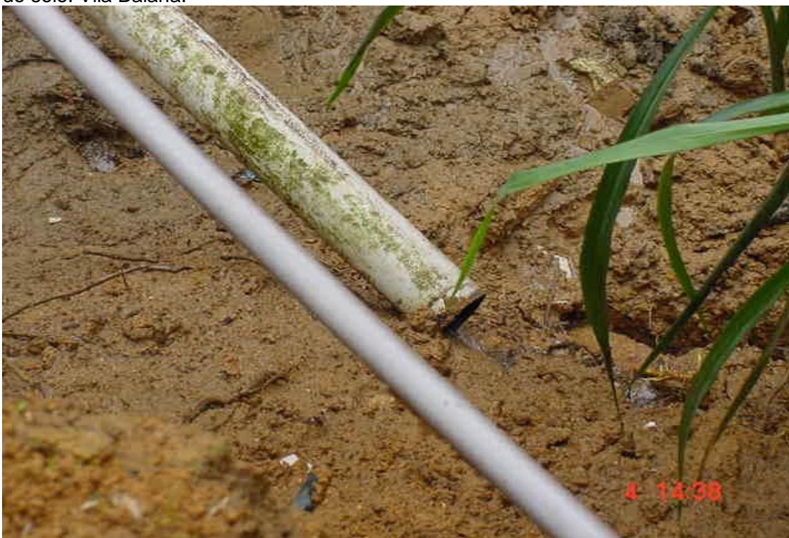
Fotografia 03: Despejo de água servida diretamente no talude, ocasionando saturação do solo. Vila Baiana.
