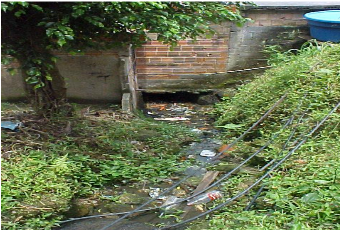
Fotografia 54: Drenagem natural assoreada passa por debaixo das casas com muito lixo e esgoto lançados. Vila Baiana.
