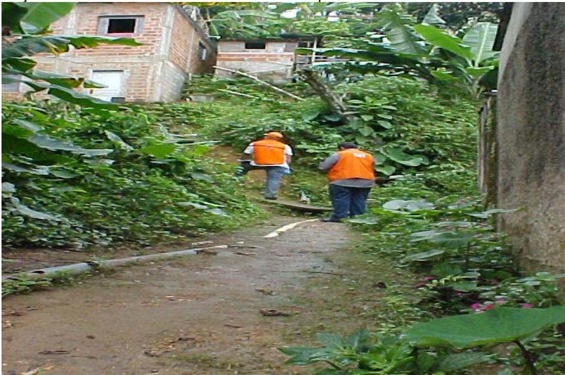
Fotografia 32: Casas em taludes de corte altos e íngremes, com águas servidas lançadas e vazamentos no sistema hidráulico improvisado. Jardim Três Marias.
