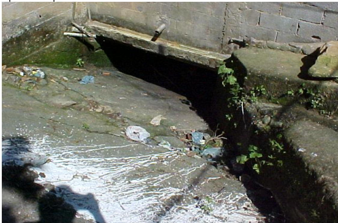
Fotografia 44: Maciço rochoso transformado em sistema de drenagem de superfície improvisado. Vila Baiana.
