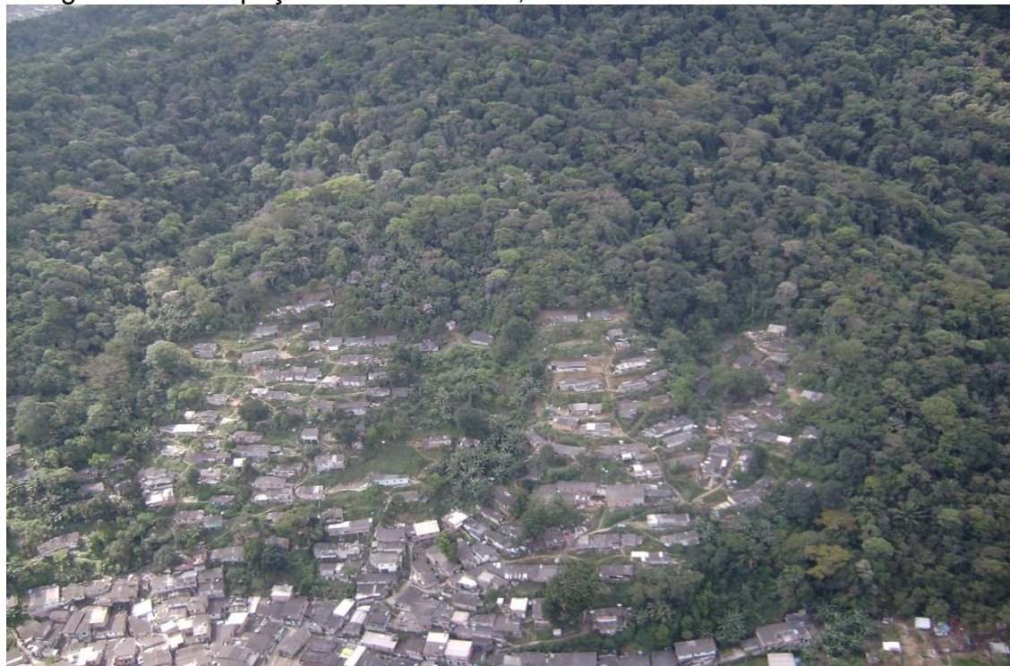
Fotografia 37: Ocupação em declividade, desestabilizando o talude.
