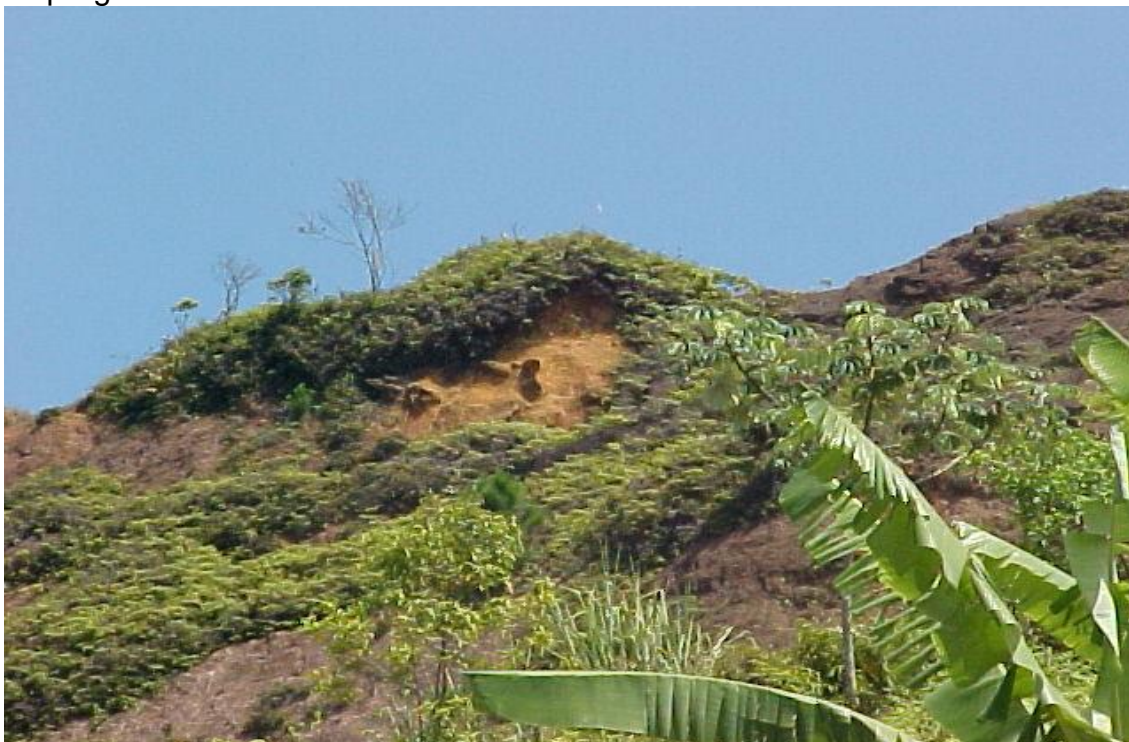
Fotografia 59: Detalhe do topo da encosta natural. Intensa erosão e despregamento de blocos. Barreira do João Guarda.
