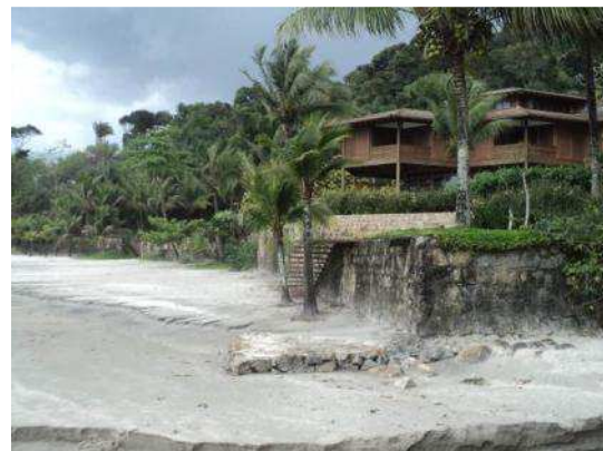
Figura 13. Residências de alto padrão próximas à praia no Loteamento Tijucopava.
