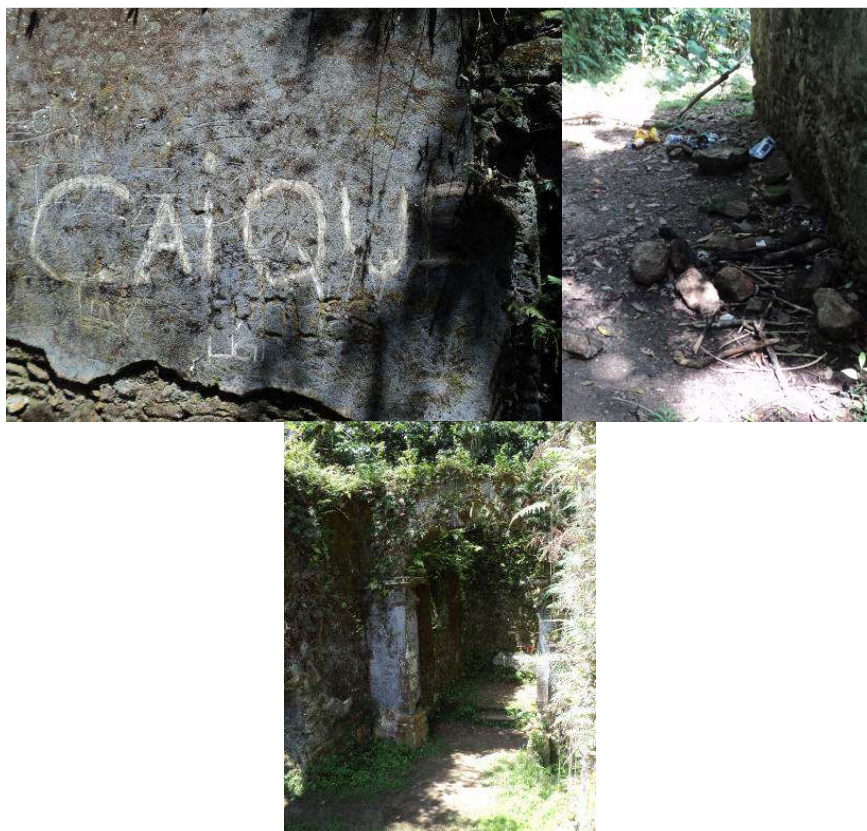
Figura 70. Exemplos da má conservação do patrimônio. Pichações, restos de lixo e fogueira e excesso de vegetação crescendo sobre as ruínas.
