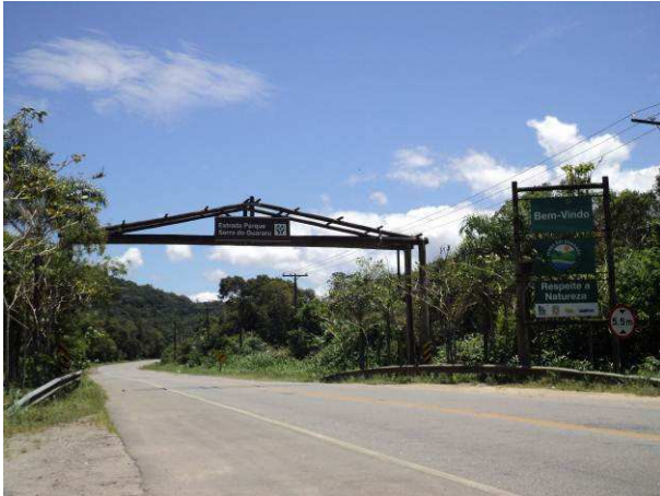
Figura 75. Pórtico da Estrada Parque da Serra do Guararu, na Rodovia SP-061
