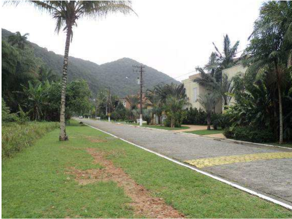
Figura 42. Via interna com acesso a residências no Loteamento Taguaíba.
