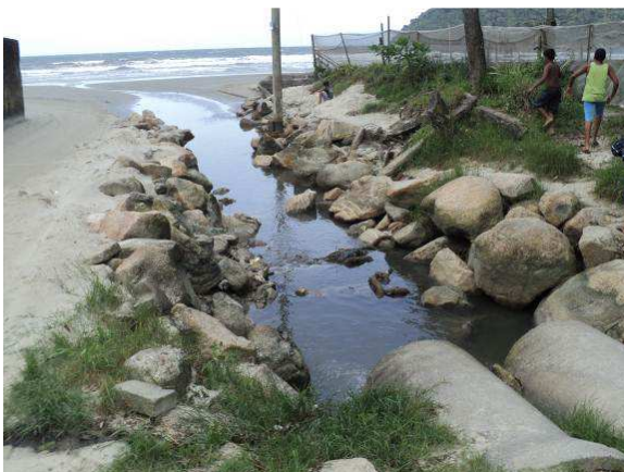
Figura 48. Esgoto lançado in natura no mar, na região do Fundão.
