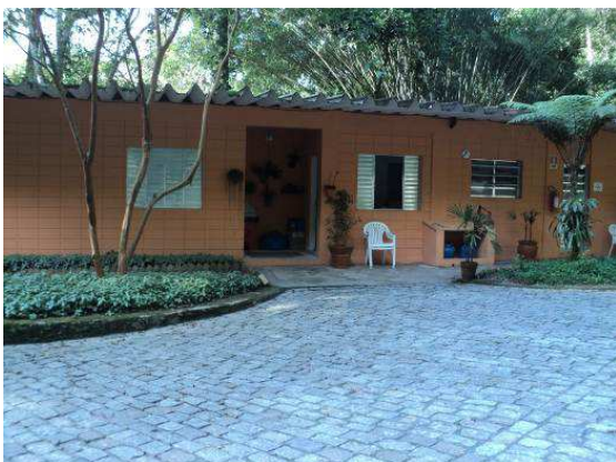
Figura 44. Prédio da administração do Loteamento São Pedro.
