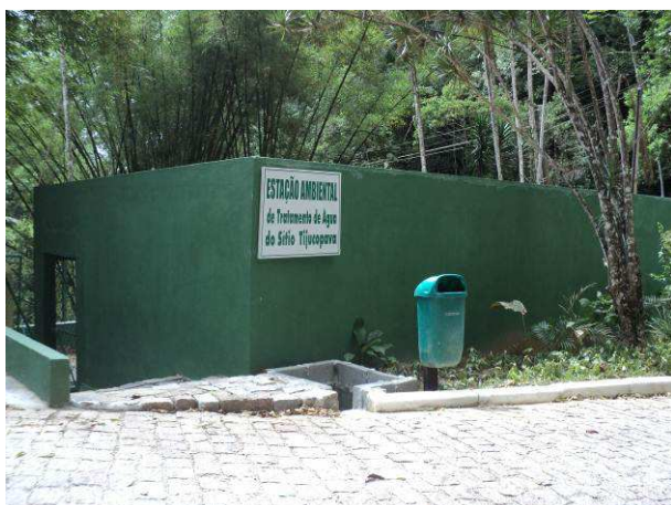
Figura 41. Estação de Tratamento de Água do Loteamento Tijucopava.
