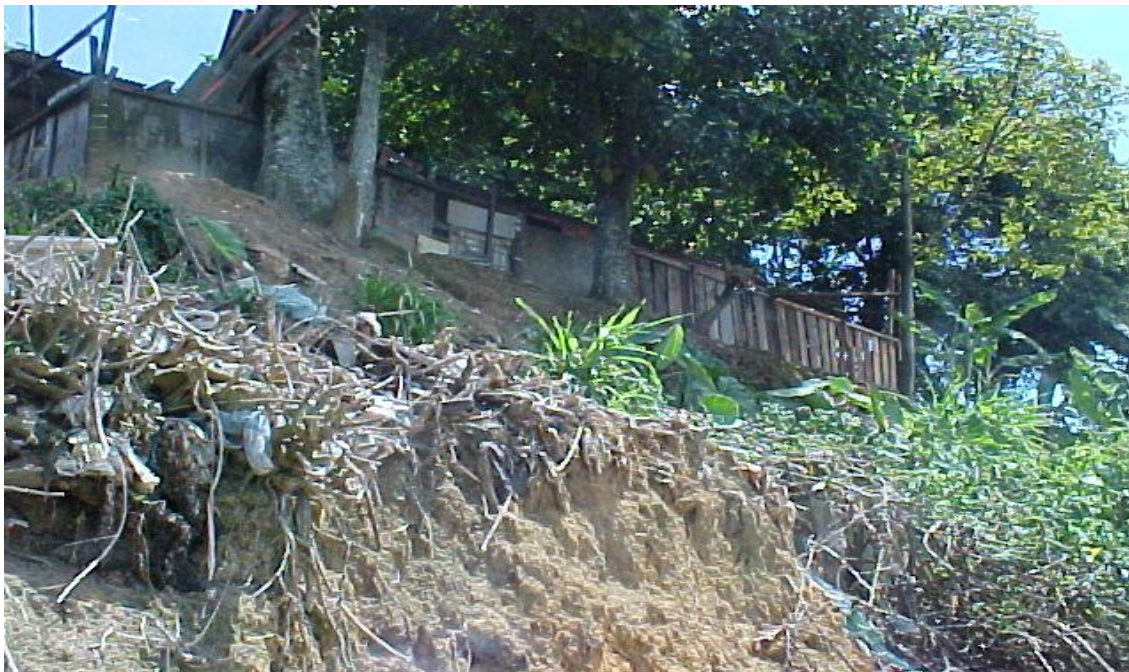
Fotografia 48: Depósito de lixo sobre talude de corte em solo residual. Vila Baiana.
