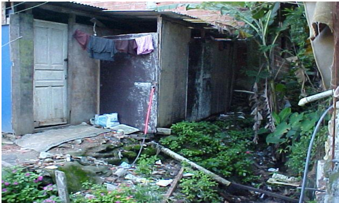
Fotografia 20: Lançamento de água servida, lixo e entulho na drenagem superficial. Vale da Morte.
