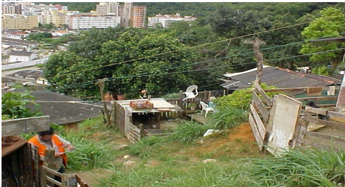
Fotografia 11: Construções precárias, em meio a taludes de corte e aterro. Vila Júlia.
