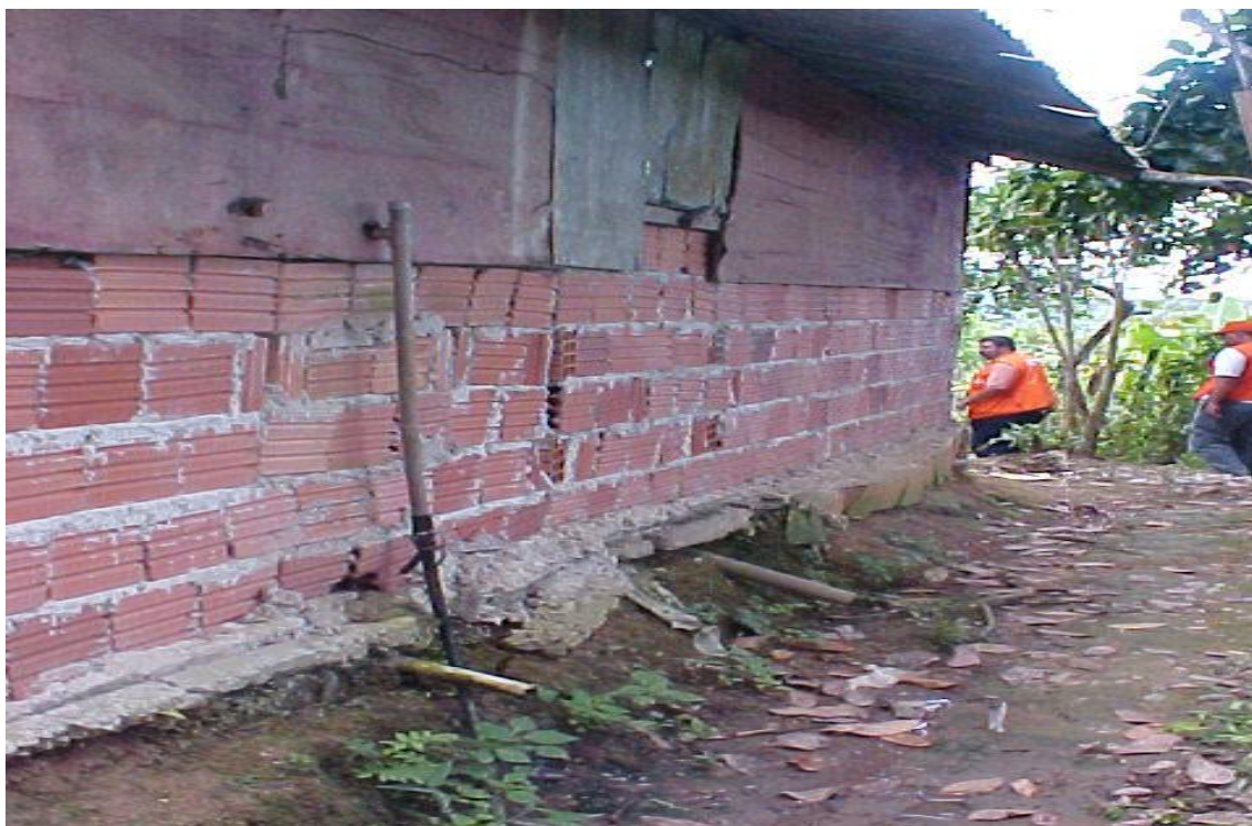
Fotografia 62: Moradia em área plana, à margem da encosta, com depósito de lixo e entulho. Nota-se o lançamento de águas servidas na lateral da casa. Canta Galo.
