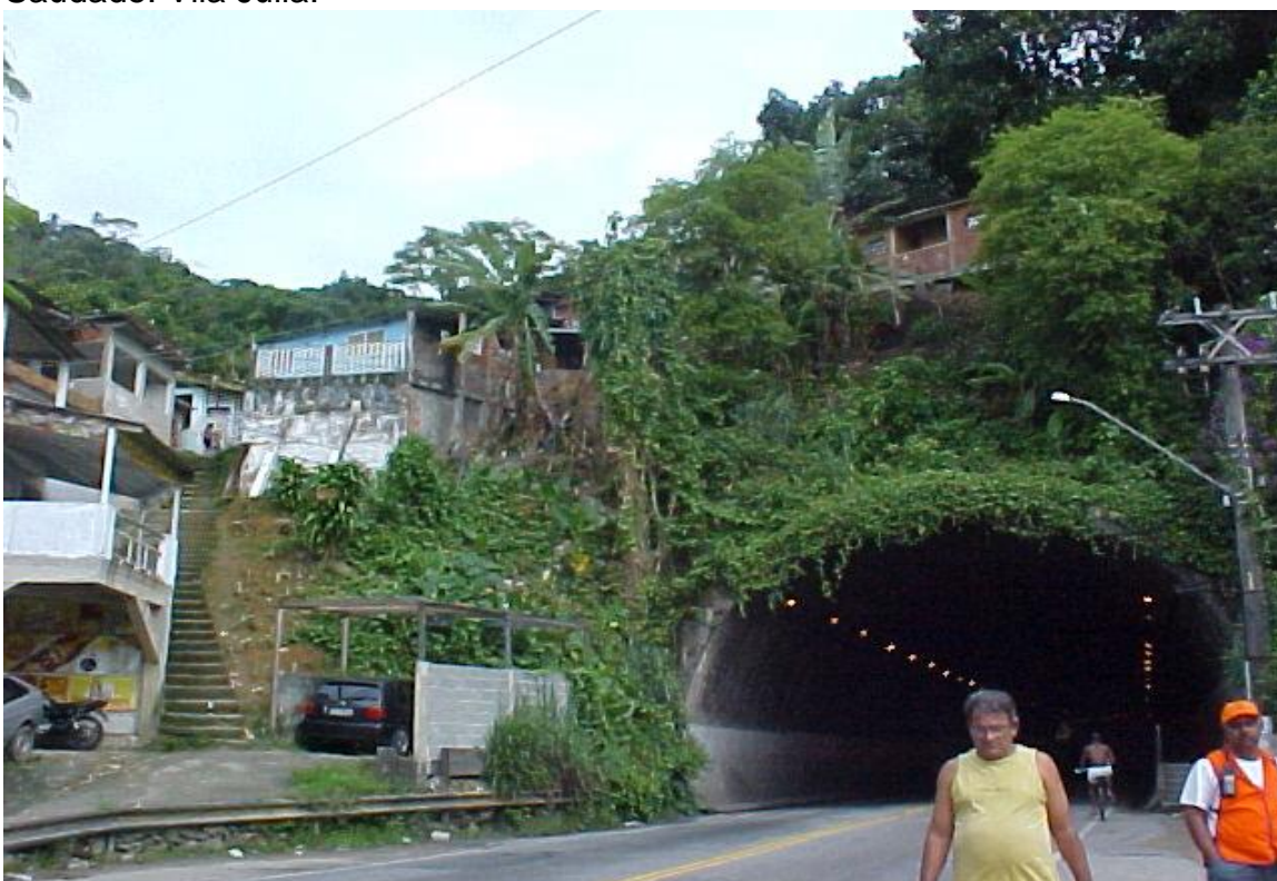
Fotografia 07: Vista geral da ocupação sobre o emboque do túnel da Avenida da Saudade. Vila Julia.
