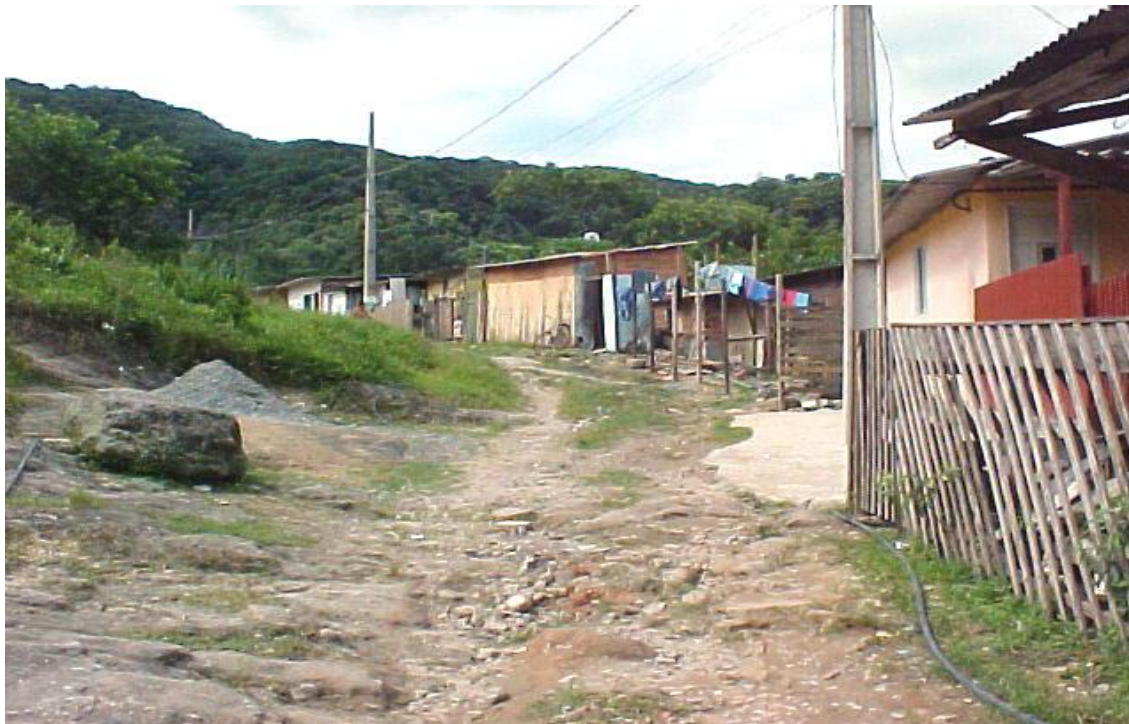
Fotografia 58: Vias sem pavimentações e sistemas de drenagens. Edificações de alvenaria e madeira. Barreira do João Guarda.
