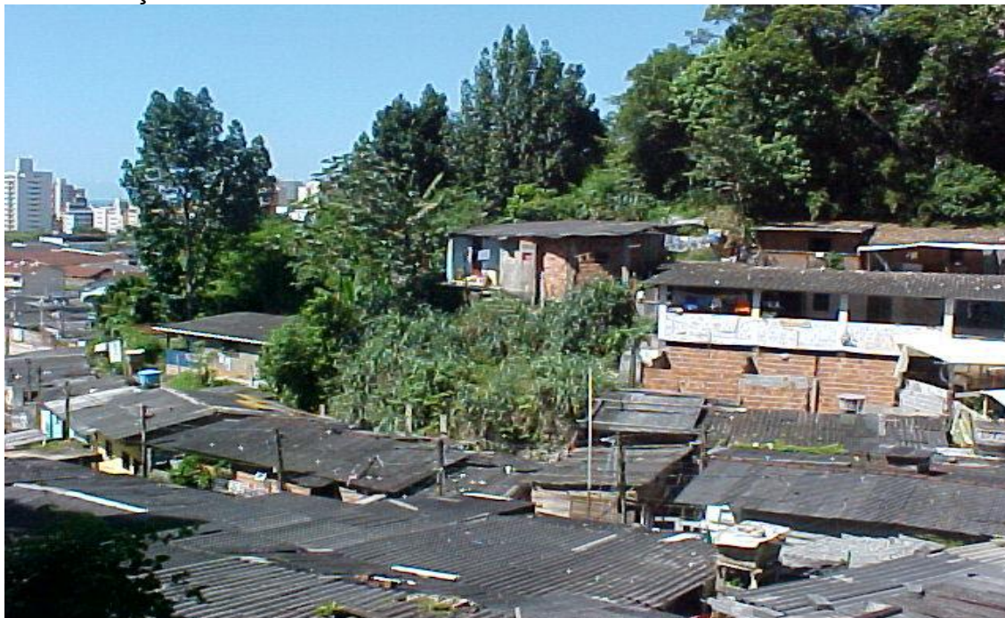
Fotografia 22: Casas de caracteres mistos. Árvores inclinadas, evidenciando a movimentação da encosta. Vale da Morte.
