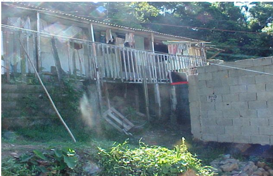
Fotografia 21: Casas mistas (alvenaria e madeira), com estrutura de sustentação modelo palafita sobre o talude de aterro, com vala de drenagem de águas superficiais na base. Na porção mais baixa, blocos são usados para conter a erosão.
