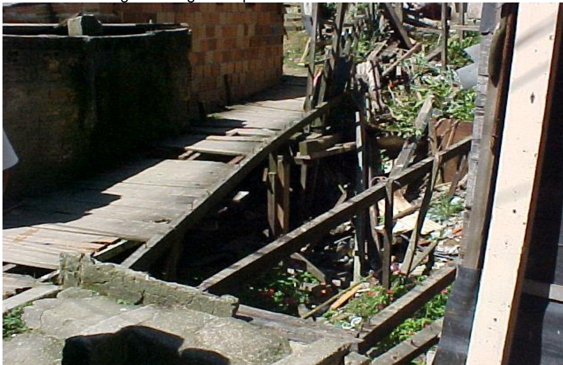
Fotografia 24: O acesso danificado às moradias, decorrente da precariedade do sistema de drenagem de águas superficiais. Vale da Morte.
