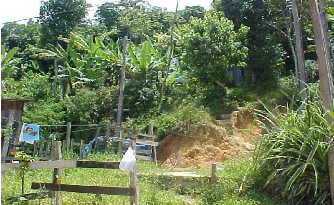
Fotografia 66: Moradias implantadas no alto de um talude de corte mal executado com cicatrizes de escorregamento. Canta Galo.
