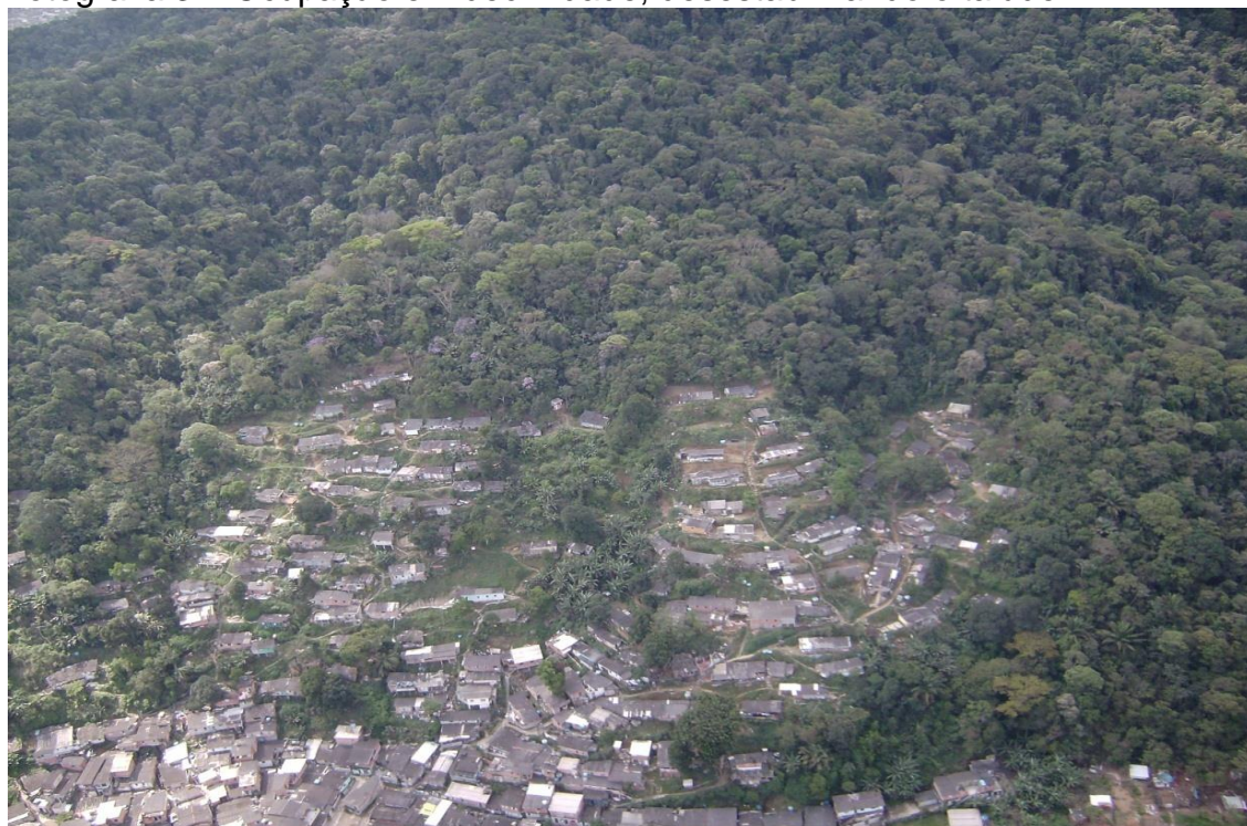
Fotografia 37: Ocupação em declividade, desestabilizando o talude.
