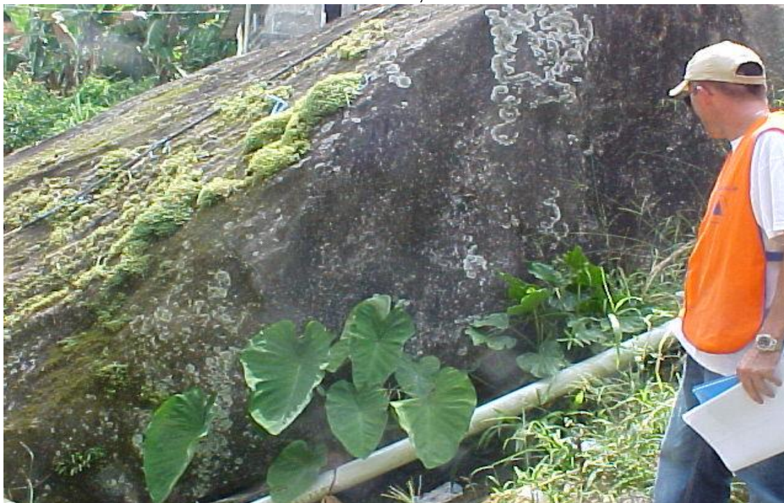
Fotografia 49: Matacão de dimensões métricas em meio às casas de alvenaria. Notar canos de lançamento de águas servidas na base e mangueiras de abastecimento de água no topo. Ambos os sistemas possuem vazamentos que carregam material fino da base do matacão, soltando-o do terreno. Vila Baiana.
