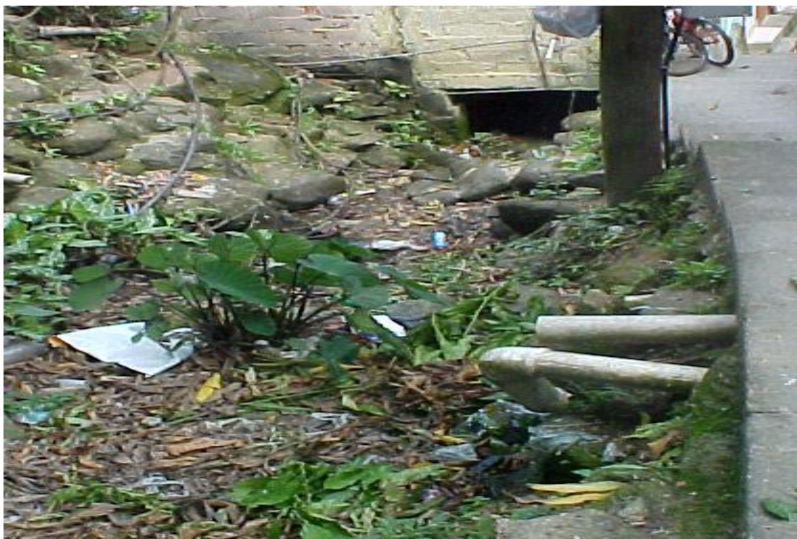
Fotografia 51: Drenagem natural, retificada pela implantação de escadaria de pedestres. Notar lançamento de águas servidas e a presença de matacões. Vila Baiana.
